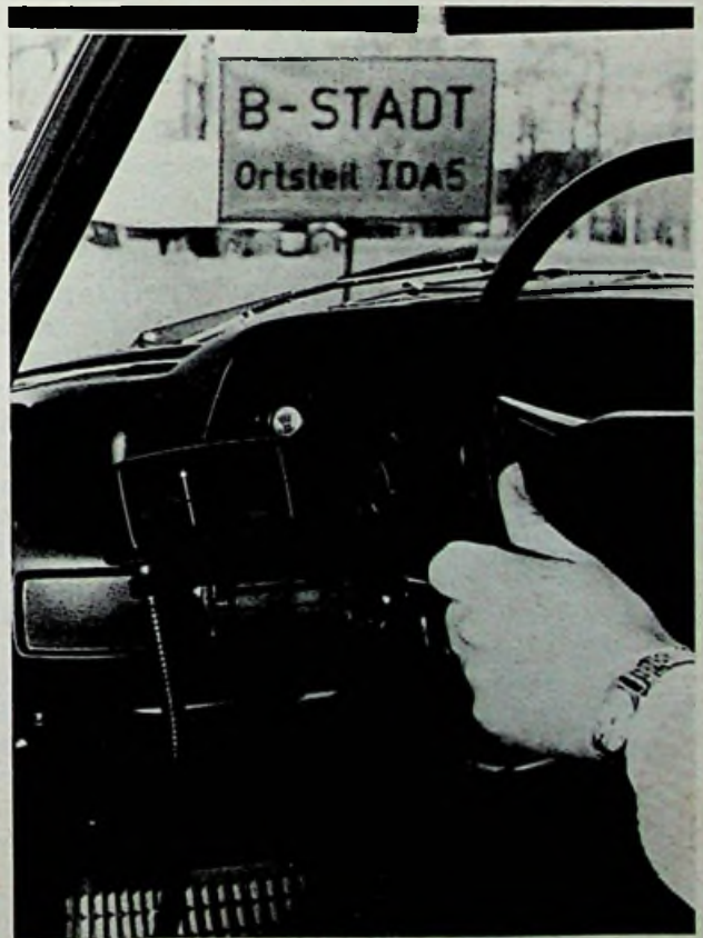
Afb. 2. Op een paneeltje geven drie pijlen aan in welke richting gereden dient te worden. Voorts wordt informatie omtrent adviessnelheden en bijv. mist, gladheid of verkeersopstoppingen. Door de voorruit is de letter/cijferindicatie van B-stad zichtbaar: IDA5.
